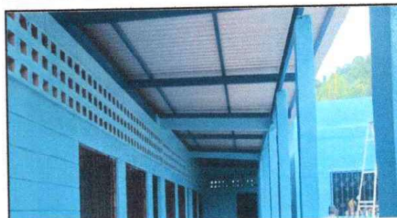
FOTO 4: Sustitución de estructura de soporte de madera, por metal EN AULAS
