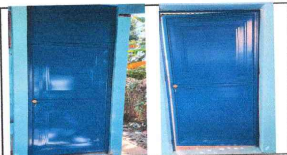
FOTO 5: Sustitución de puerta EN AULAS
