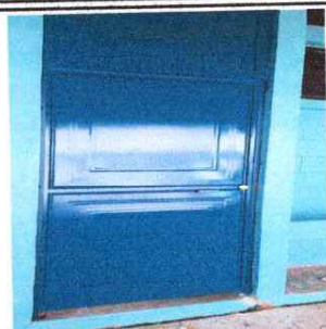
FOTO 1: Mantenimiento a estructura (lijado, cambio de tubo, cepillado, sujeciones, aplicación de pintura) PUERTA EN BAÑOS
