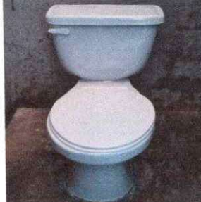
FOTO 2: Sustitución inodoro en baños
