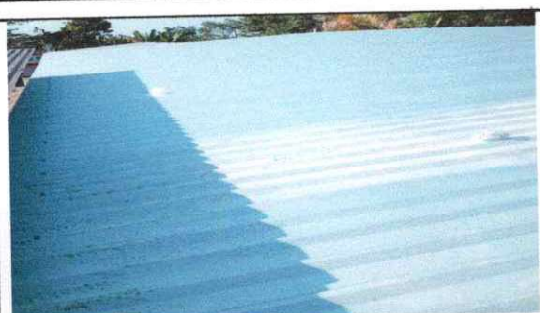
FOTO 3: Sustitución de lámina, por lámina troquelada aluzinc calibre 26 EN AULAS
